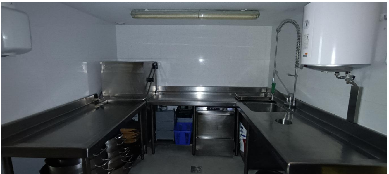
Figura 11: Vista interior, cocina
