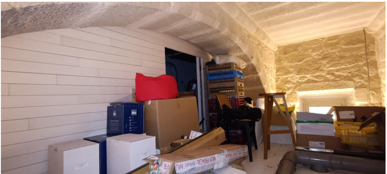
Figura 19: Vista interior, techo aseos
