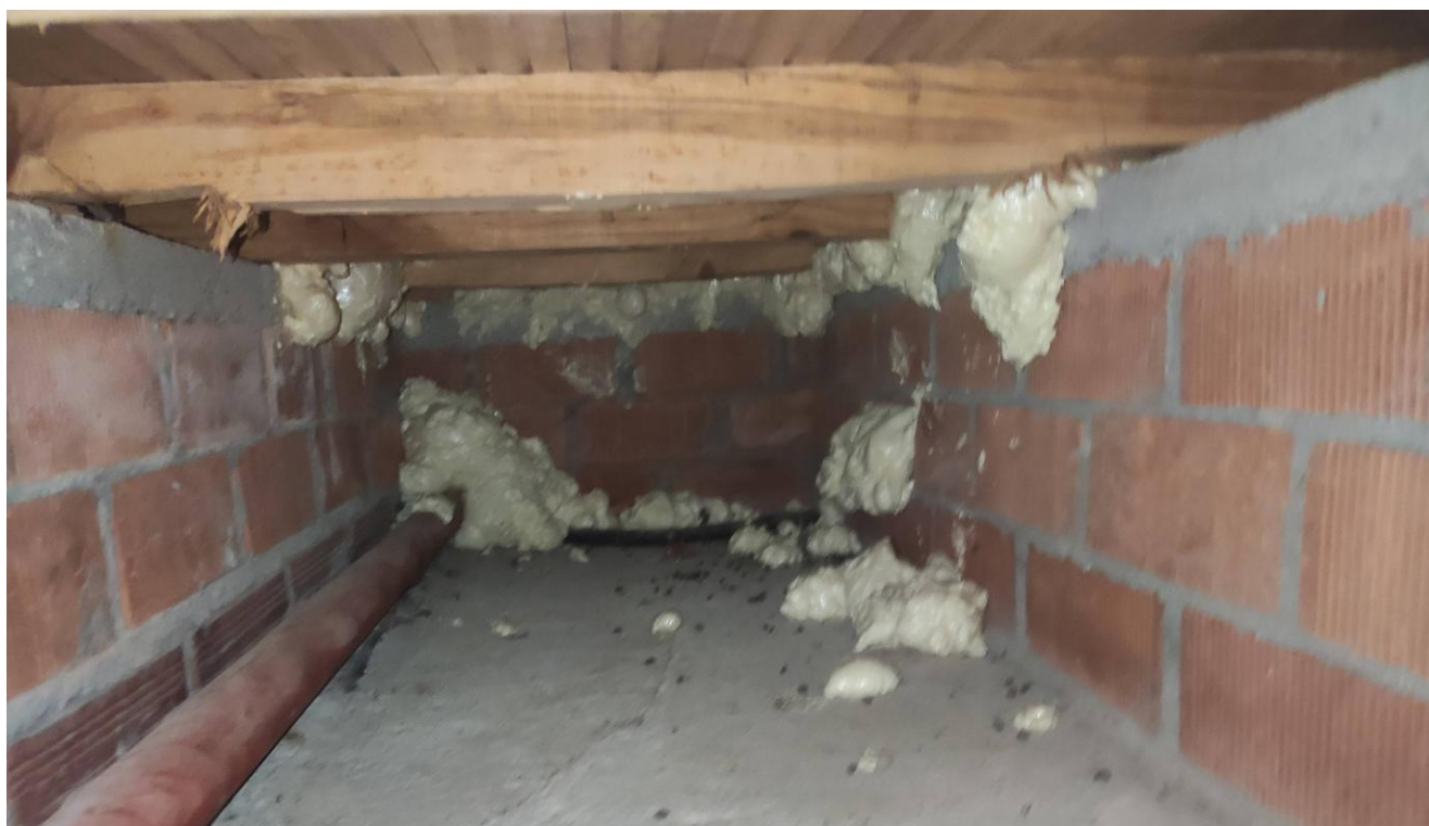
Figura 15: Vista interior, detalle pavimento existente
