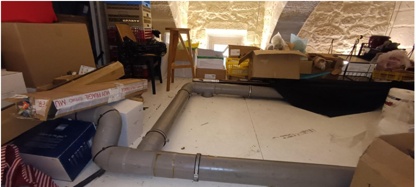
Figura 18: Vista interior, techo aseos
