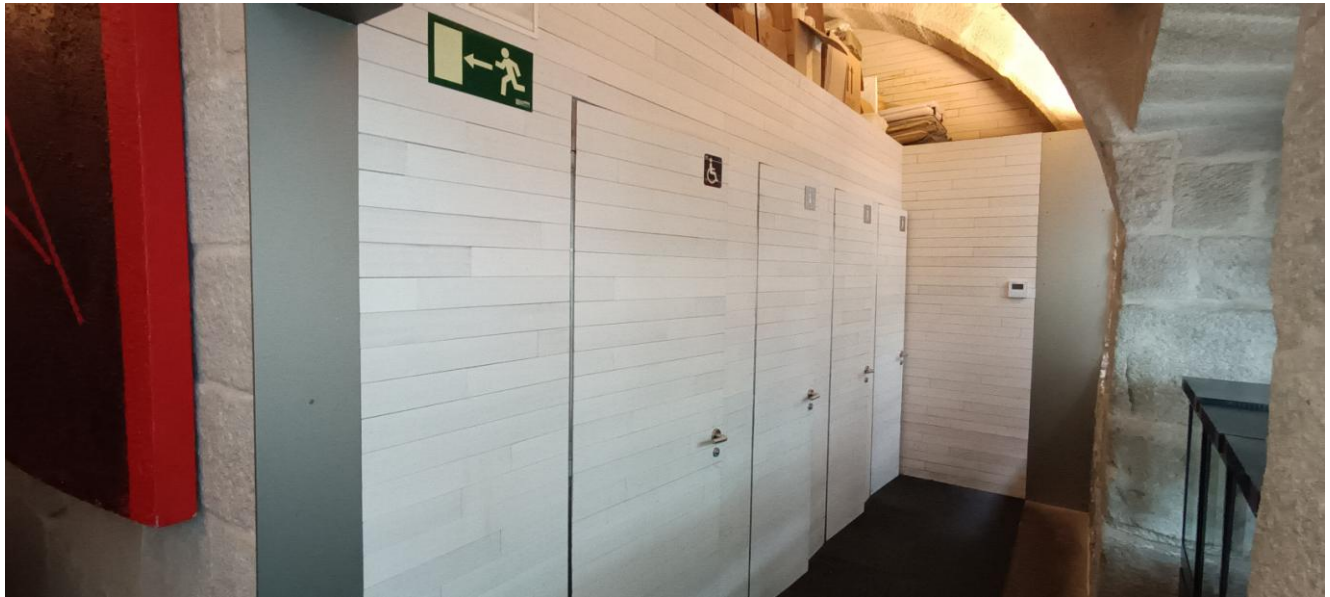
Figura 20: Vista interior, pasillo acceso a aseoa
