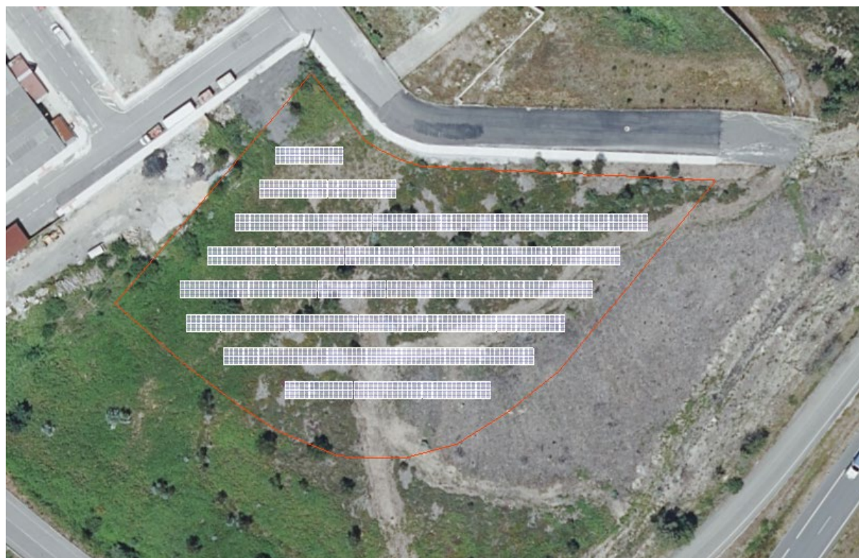
Figura 8. Instalación fotovoltaica na parcela
