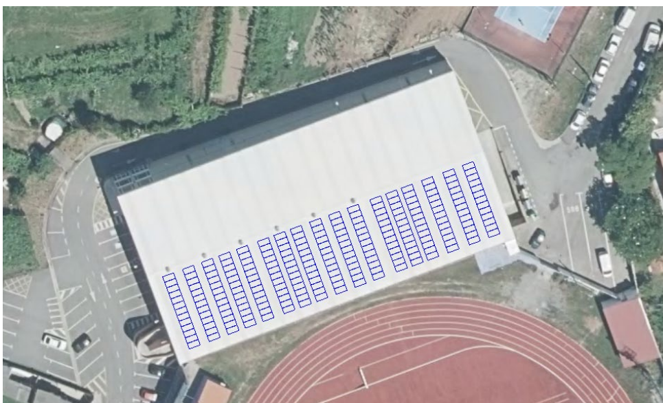
Figura 7. Cubertas pavillón San Pedro
