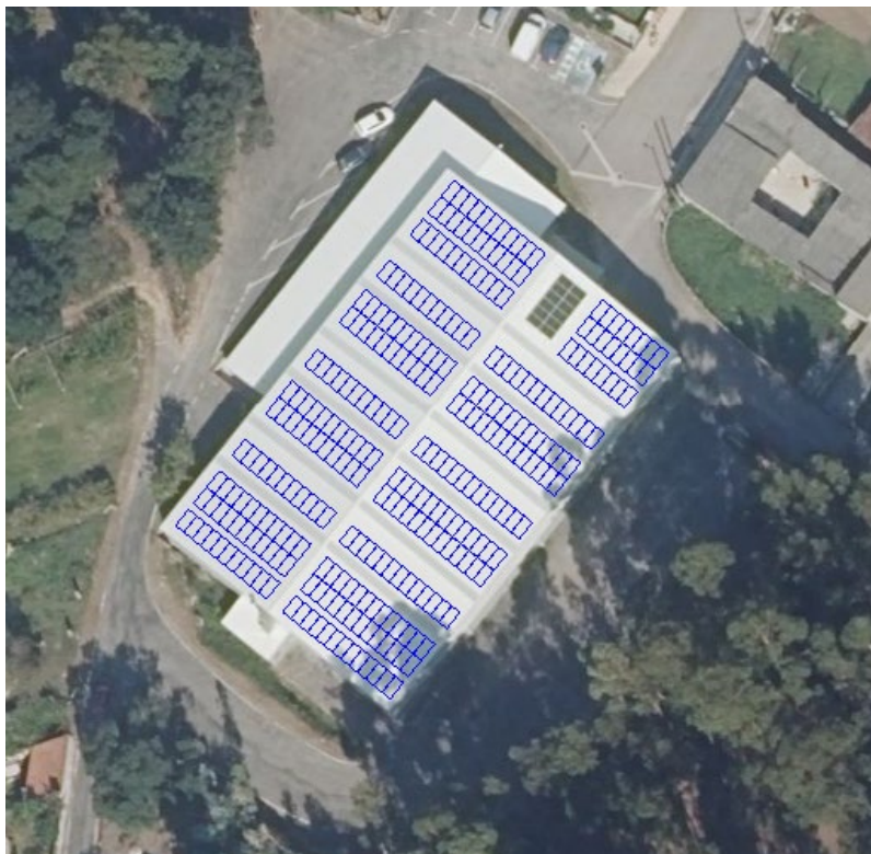
Figura 7. Cuberta pavillón municipal
