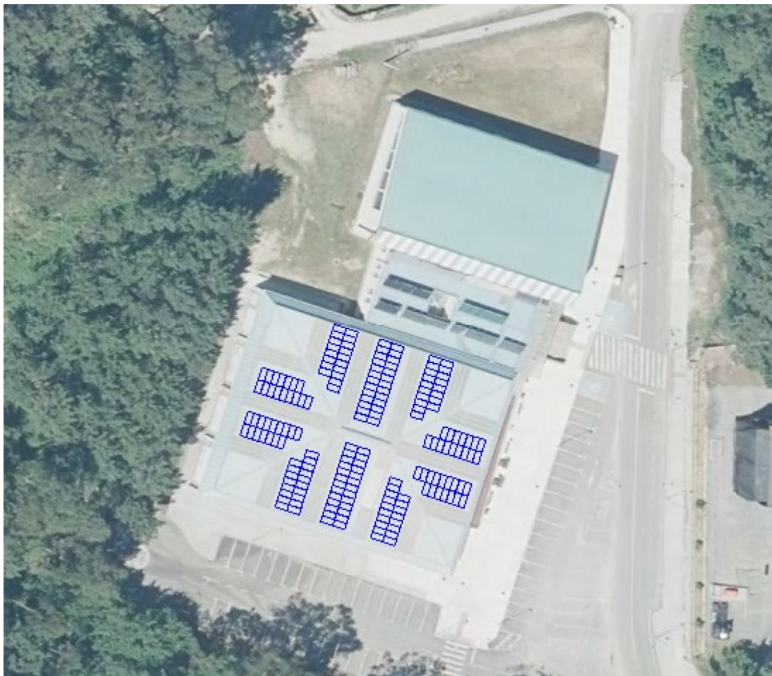
Figura 8. Cubertas pavillón e piscina municipal Óscar Pereiro
