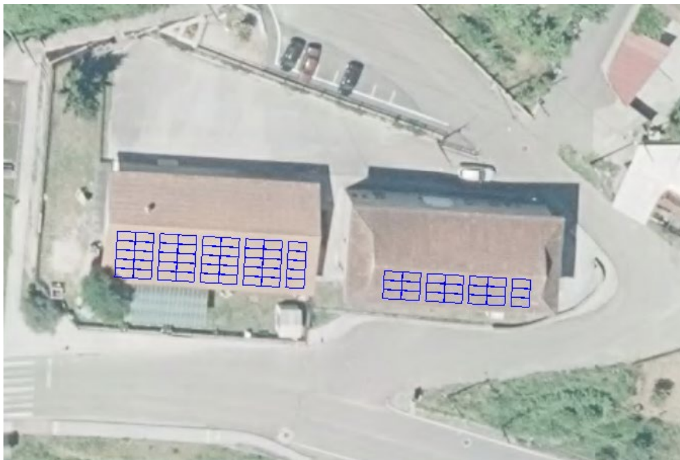
Figura 7. Cubertas edificio biblioteca de gardería Porteliña
