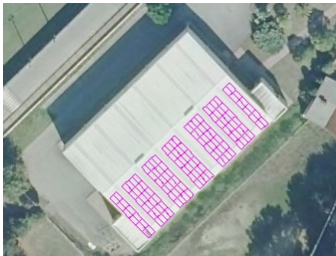
Figura 6. Cuberta pavillón Baño
