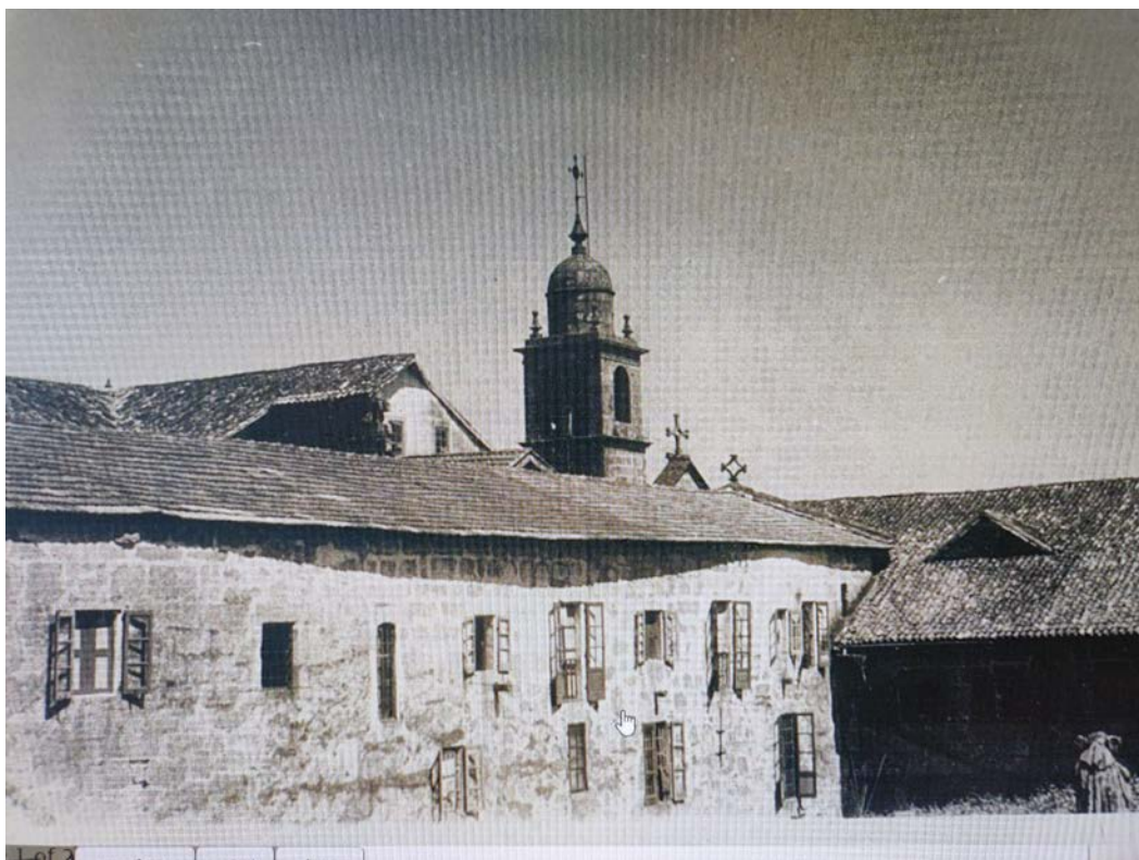
Convento en 1976, antes da intervención do tellado da igrexa.
