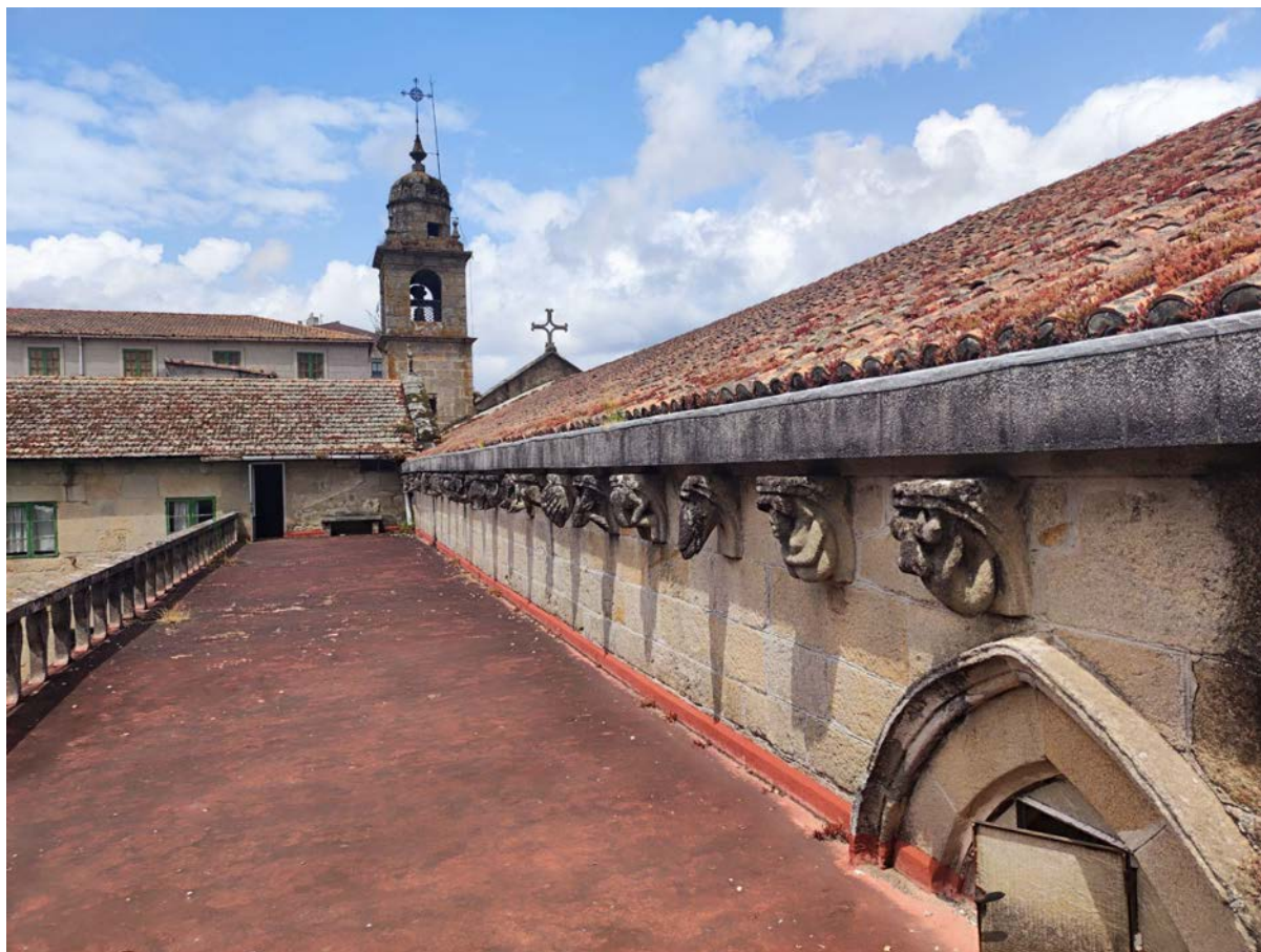
Terraza de Todos os Santos, cachorrada gótica, s. XIV, da fachada sur.
