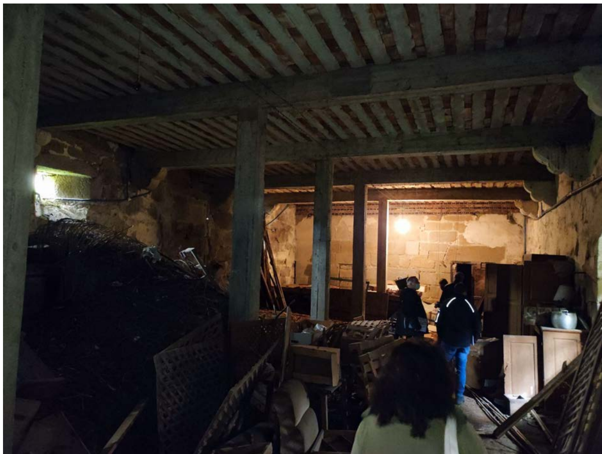
Refectorio, s. XVI, sollado de formigón das obras de 1959.
