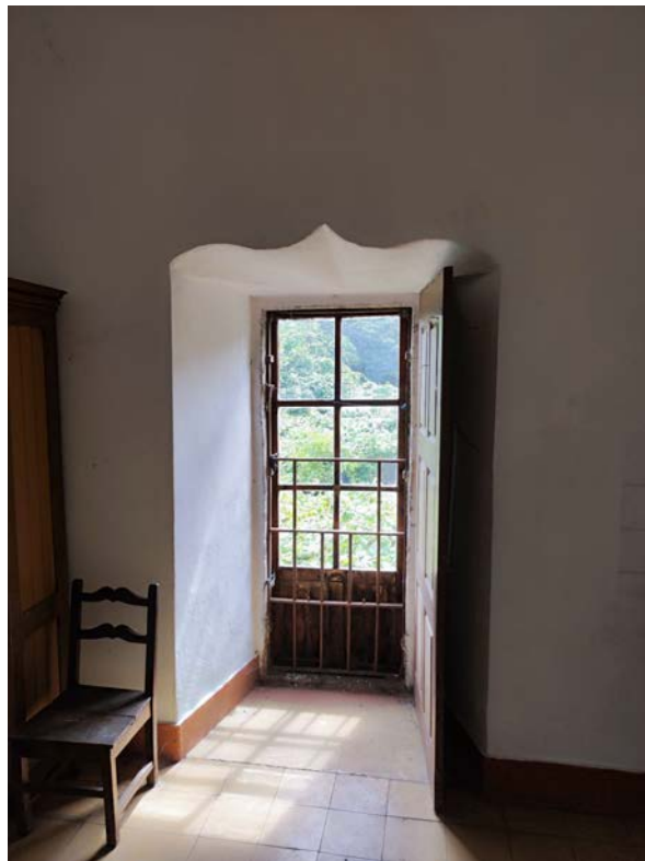
Xanela con arco conopial da extremo da panda occidental, ao claustro, s. XVI.
