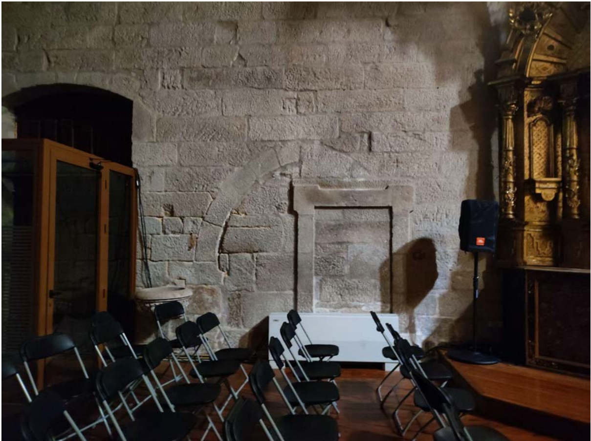
Porta da sancristía de 1773 e arcosolio gótico deturpado pola obra barroca.
