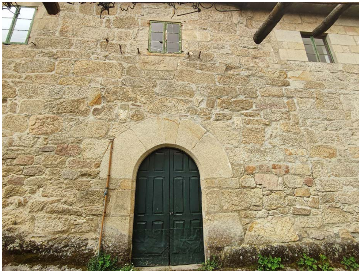
Porta do s. XVI na panda oeste, edificio do refectorio.
