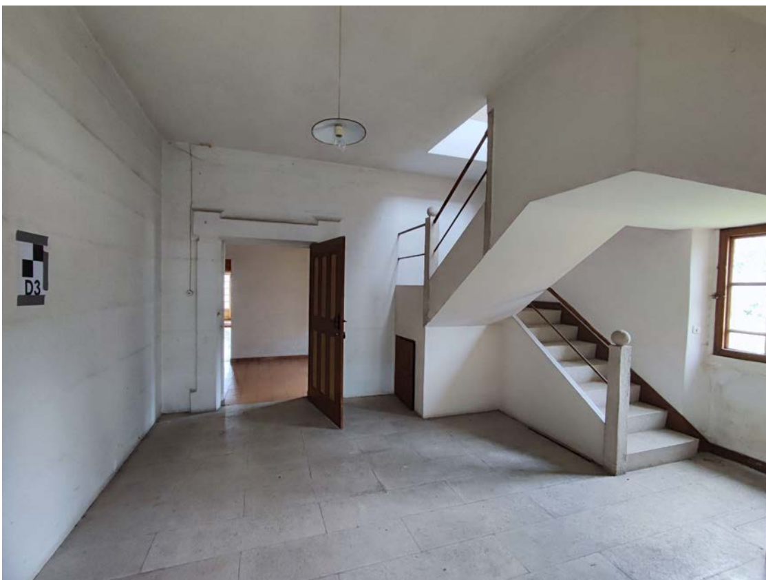
Interior de celda, no edificio barroco, con recercado na porta, e escaleiras de acceso ao baixo cuberta.
