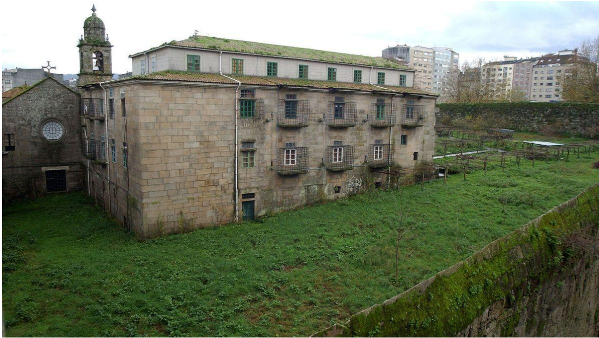
Edificio barroco de Santa Clara, zona occidental da clausura, s. XVIII.
