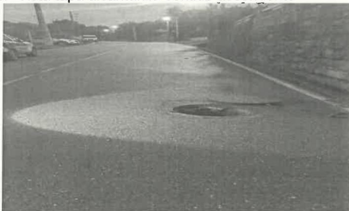
Foto 03.- Vista tapa alcantarilla sentido ascendente
