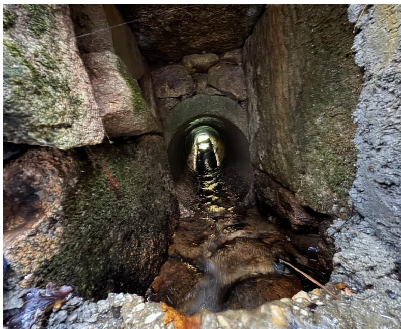
Foto da taxea preexistente que atravesa a estrada, a súa construción, tal e como se pode observar cos materiais de pedra cos que está feita, é moi antiga
