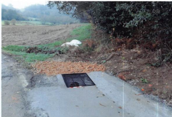
Fotografía nº 3 Vista general de la entrada de la tajea en la parte opuesta de la carretera
