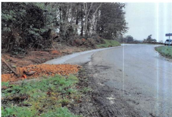
Fotografía nº 4 Vista general del tramo de cuneta cementado más próximo a la entrada de la tajea
