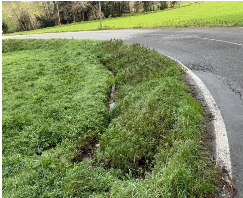
Foto do canal en terras que xa atravesaba a finca privada á saída da taxea preexistente, conducindo as augas pluviais cara o río
