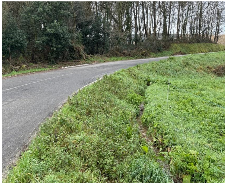
Foto do canal en terras que xa atravesaba a finca privada á saída da taxea preexistente, conducindo as augas pluviais cara o río
