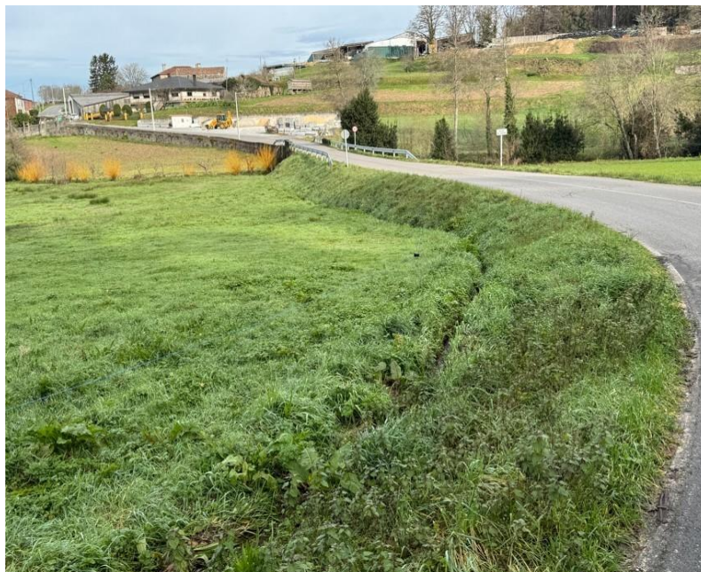
Foto do canal en terras preexistente que xa atravesaba a finca privada á saída da taxea preexistente, conducindo as augas pluviais cara o río
