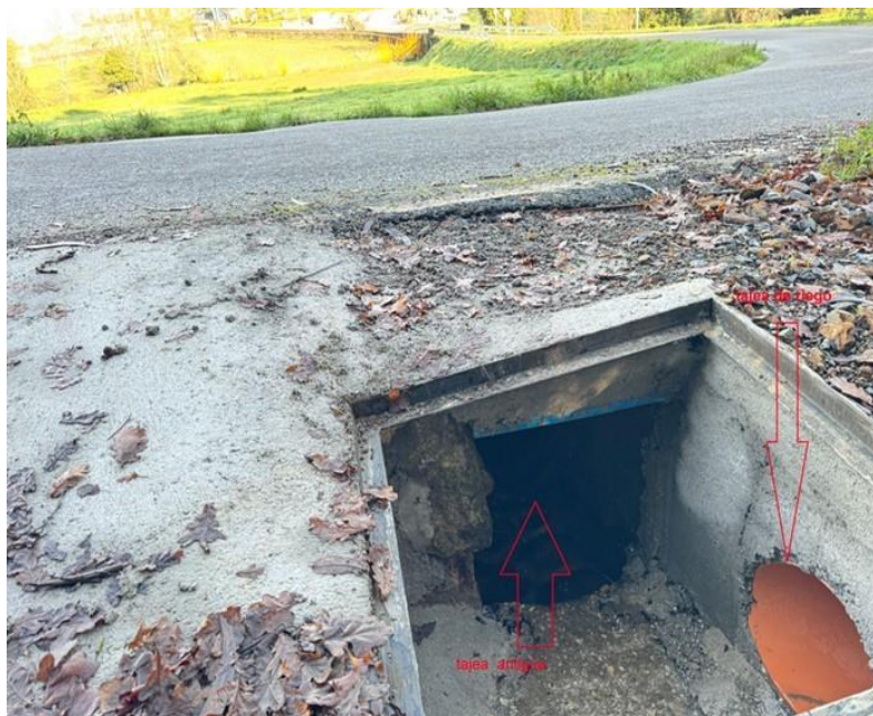
Foto da arqueta construída xunto a taxea preexistente que atravesa a estrada, pódese observar o tubo de rego que se instalou para manter dito servizo
