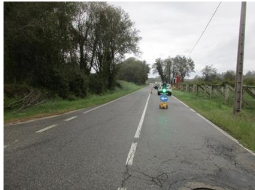
Detalle do punto de control de tráfico
