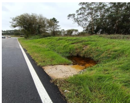
Detalle da formación dunha pequena balsa de auga na zona do sinistro
